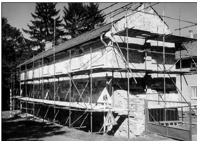
Oprava klášterní kaple
