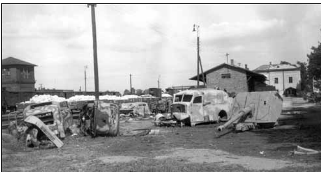
Na jaře 1945 byl komerční obvod stanice zaplněn zničenou bojovou technikou. Vlevo je budova vodárny, vpravo skladiště a za ním výpravní budova. Na nejbližší koleji stojí ucelená souprava nízkostěnných vozů soukromé Studénsko-štrambersko-veřovické dráhy s nákladem vápence.
