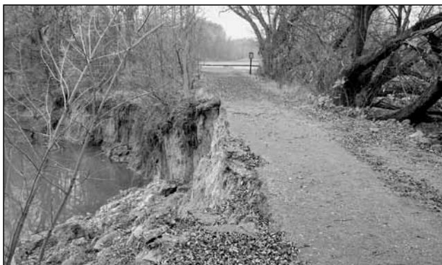
Poškozená cesta kolem rybníků (Foto Radim Jarošek)
