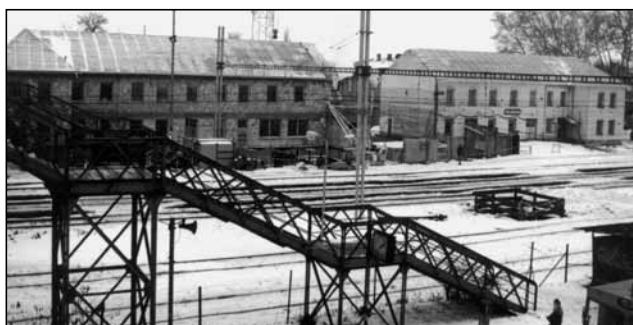
Na snímku z 8. ledna 2002 již stojí hrubá stavba nového křídla nádražní budovy (vlevo) a vzhled starší části (vpravo) je upraven snížením střechy (srovnej se snímkem z 21. 7. 2001). Chybí ještě střední vestibul.
