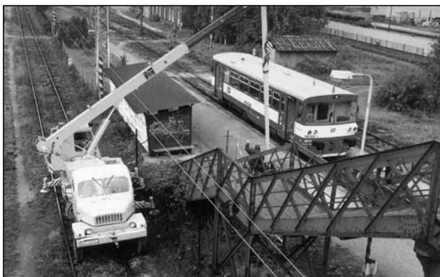
Staré bílovecké nástupiště s plechovou čekárnou a motorovým vozem 810 639-5 na vlaku do Bílovce. Dne 23. září 2001 zde byly osazovány nové sloupy trolejového vedení.
